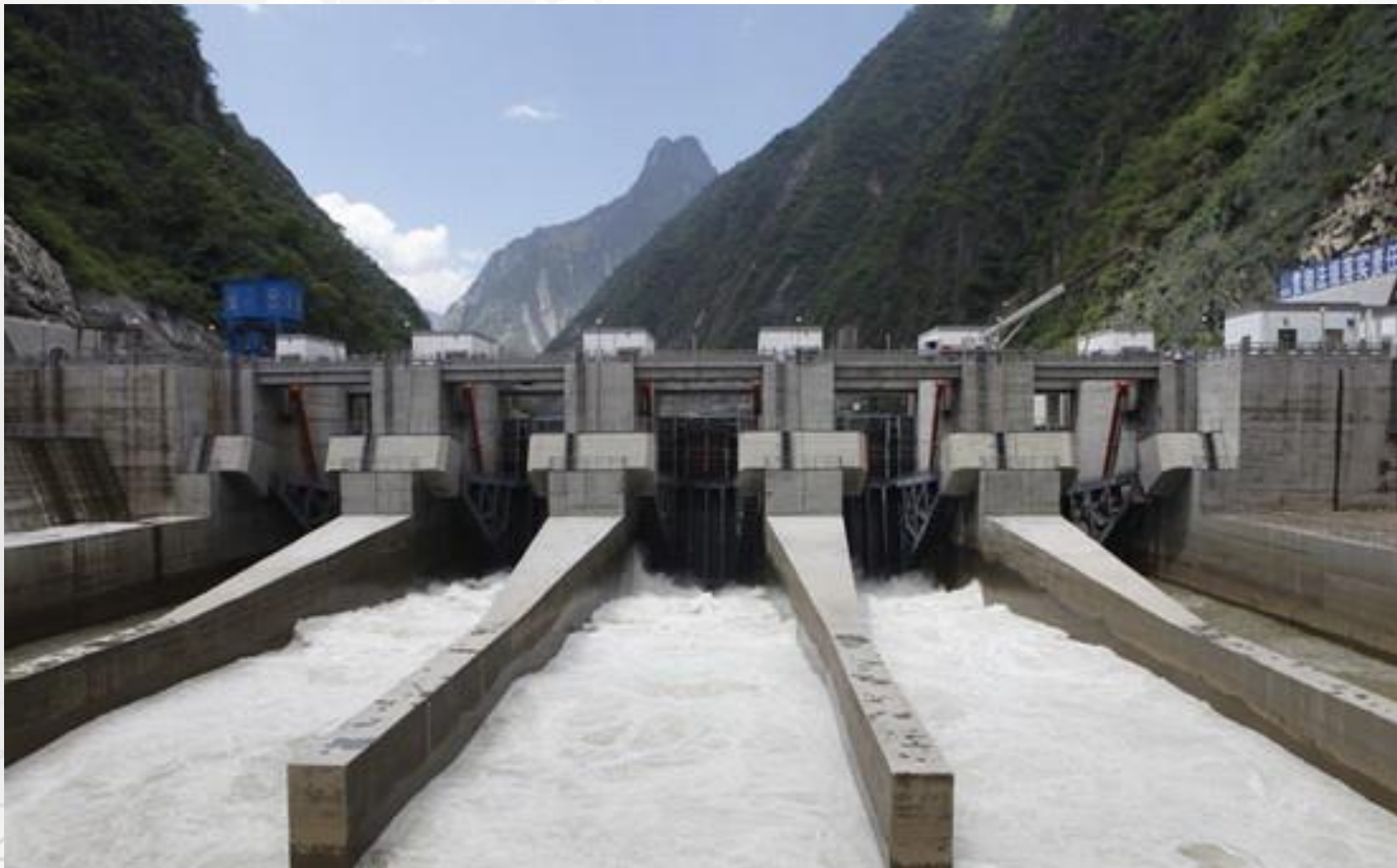
锦屏二级水电站拦河闸
