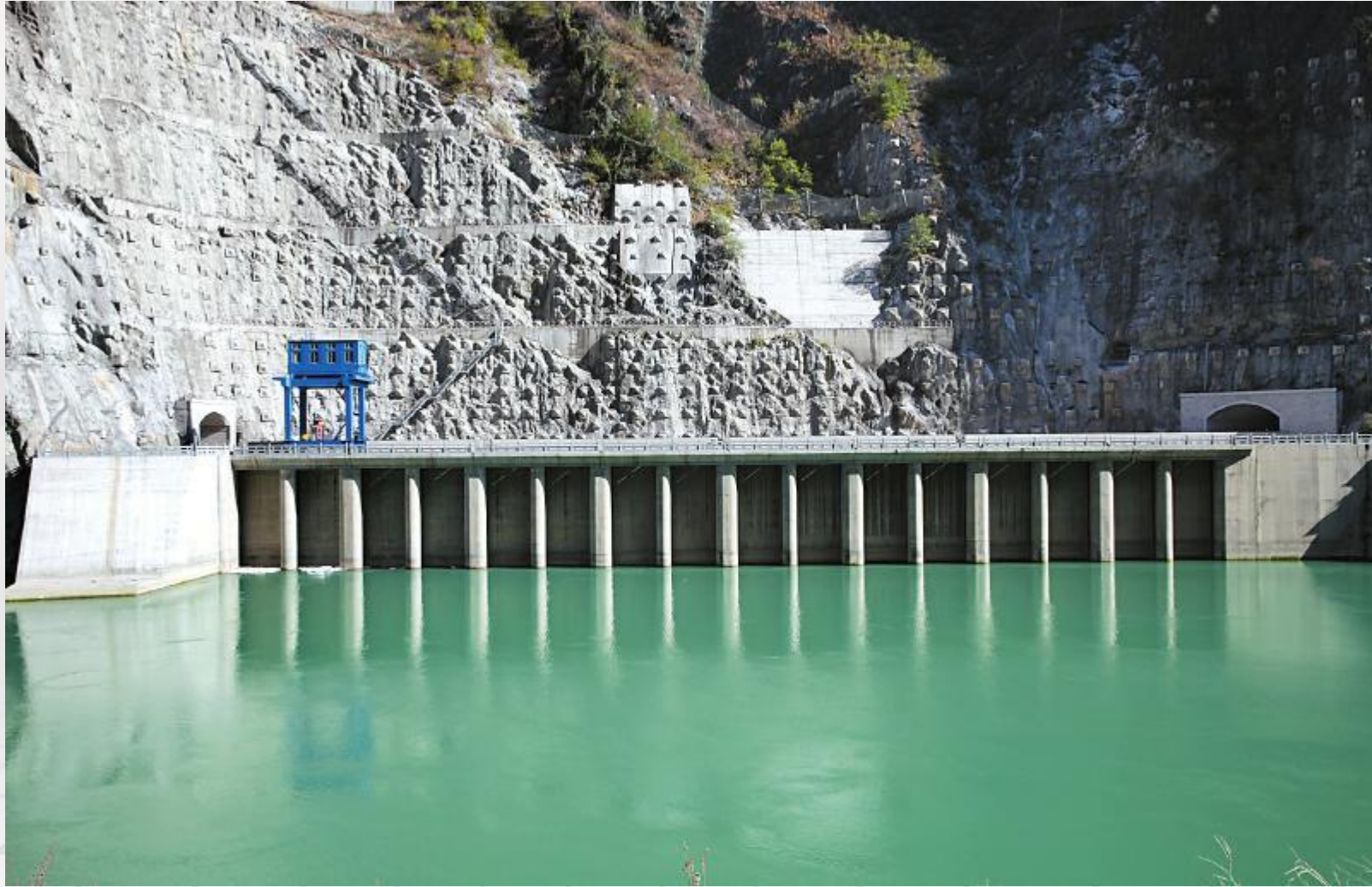
四川雅砻江锦屏二级水电站进水口
