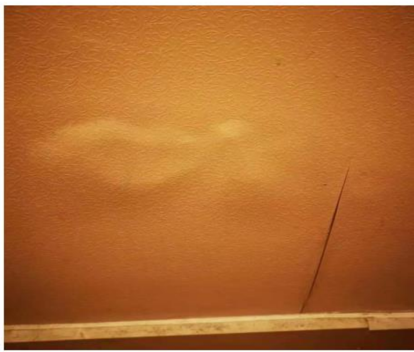
图 1 墙纸鼓包开裂
